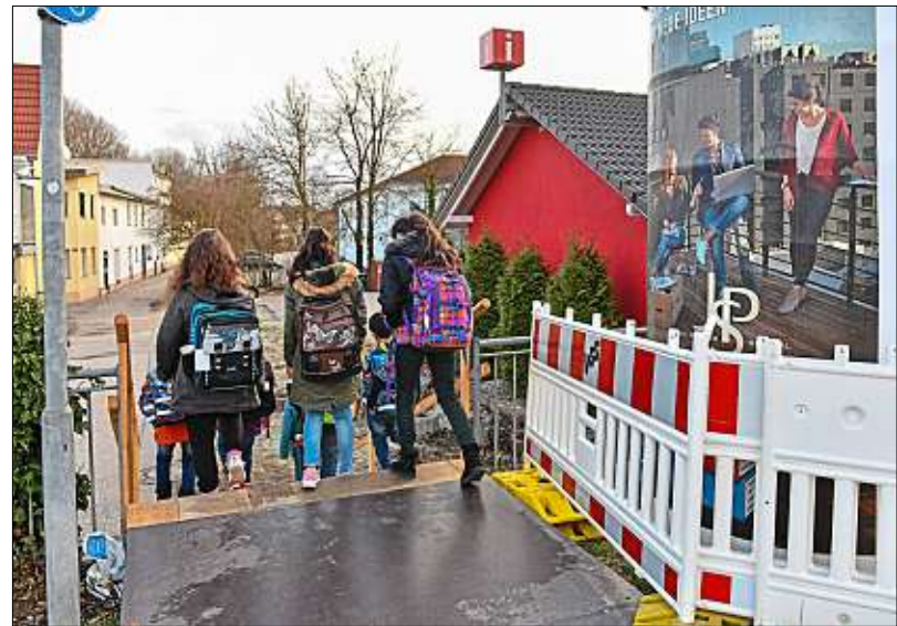
Die Schüler nehmen die extra installierte Treppe in Anspruch und gehen so der Baustelle aus dem Weg.
