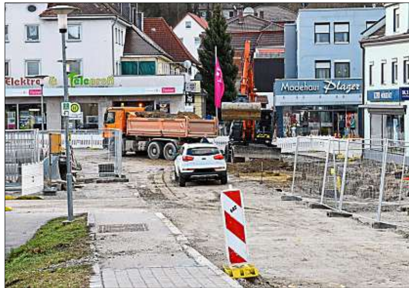
Wie immer gibt es Autofahrer, die sich nicht an Regeln halten: In diese Richtung war gesperrt und das Auto behinderte die Bauarbeiten.
